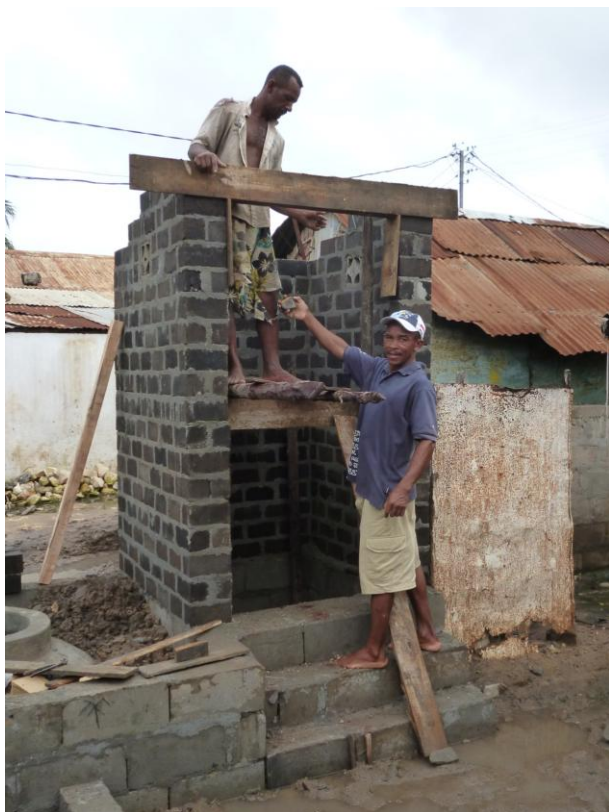
Formation pratique à la construction de latrines à fosses éanches © Enda OI
