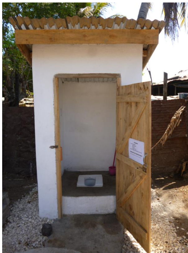
Latrines construite dans le cadre du projet ASSMA sous la coordination d'Enda OI © Enda OI
