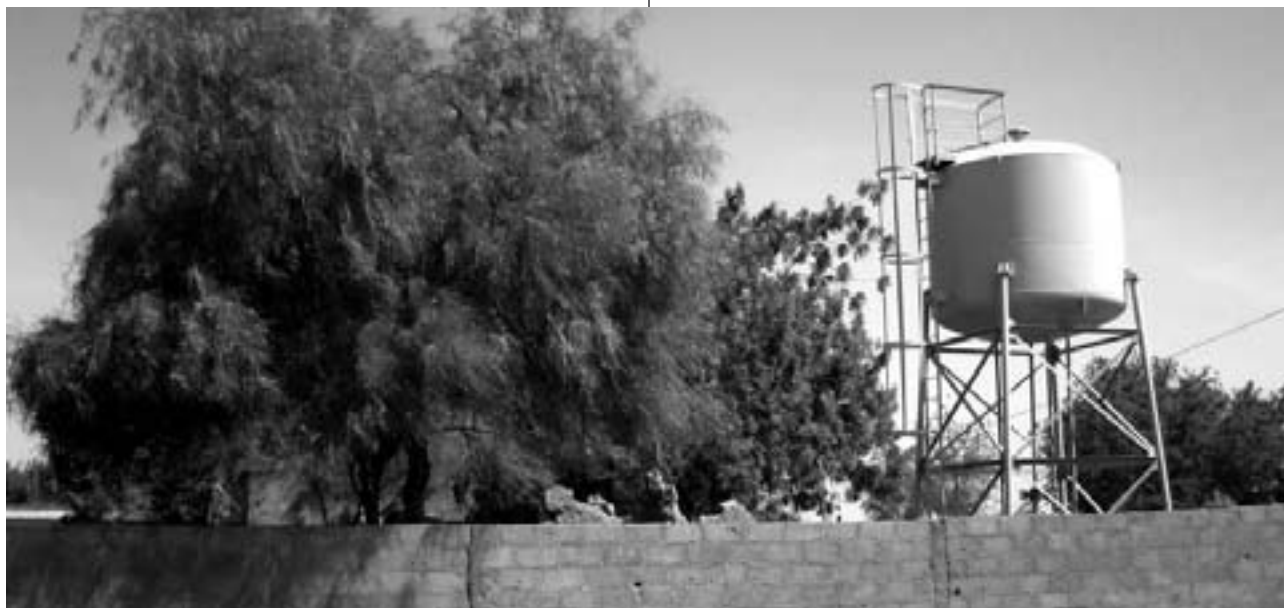
Adduction d'eau potable à Fakala.
